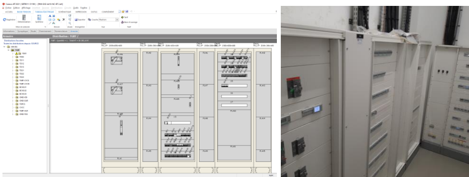
Armoire TGBT calculée dans Caneco BT
